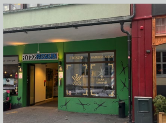
Flyttoppassasjen i Tollbugata Foto: DRMA
